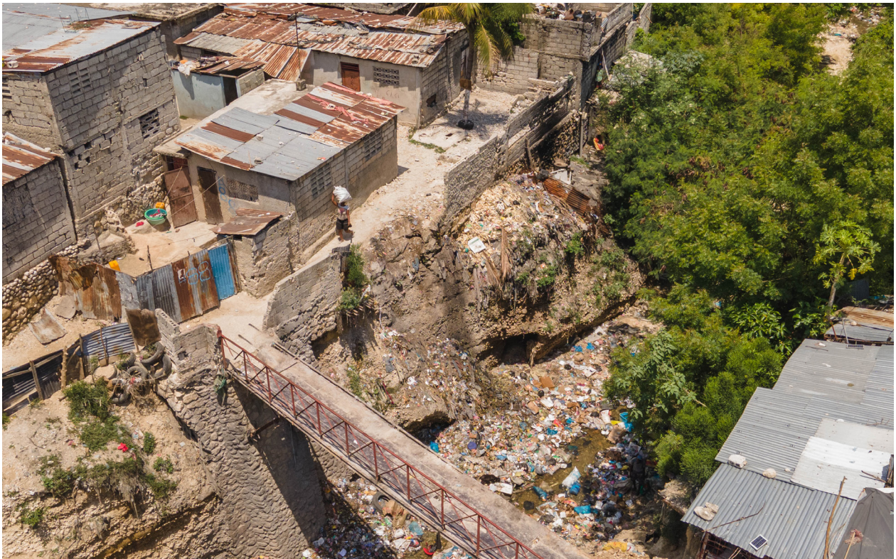
❏ A falta de gestão dos resíduos sólidos no Haiti causa impactos ambientais negativos para a saúde e afeta de forma desproporcional as pessoas que vivem em situação de pobreza. Foto: Jonathan Clement/Tearfund.
